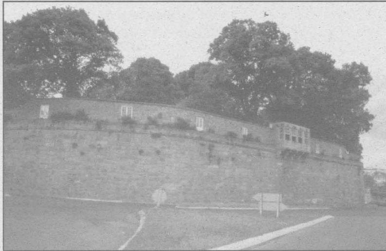
NO XARDÍN DE S. CARLOS O ESPACIO ATÓPASE REALMENTE CAPTURADO. AS ÁRBORES EMERXENDO DOS GROSOS MUROS SEMELLAN QUERER ESCAPAR. E AS XANELAS DANLLE UN AIRE DE MISTERIO QUE INVITA A ENTRAR PARA DESCUBRIR O SEGREDO.
